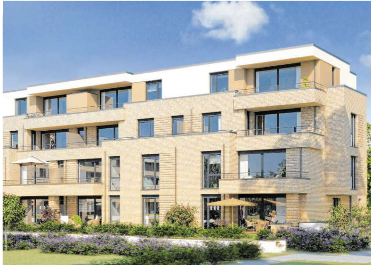
Im von Architekt Albert Jo Meyer entworfenen Projekt Nimbus orientieren sich alle Wohnungen zur Sonnenseite.
